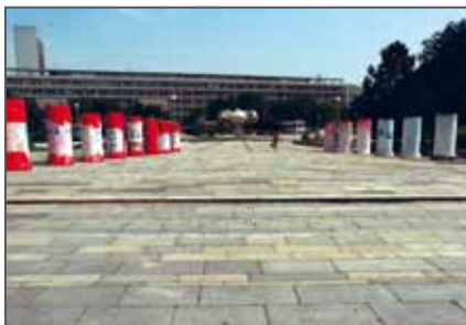
Dlažba a nefunkčná fontána na Námestí Slobody v Bratislave. Betónové skruže slúžia raz za štyri roky ako reklamné podstavce pre volebné plagáty.
